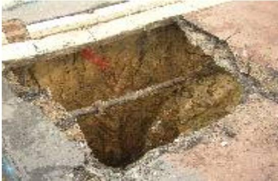
Dissolution du gypse sous une fuite du réseau d'eau potable créant un vide puis un effondrement de type fontis, Argenteuil, 2003 – source : IGC
