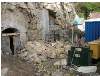
Confortement de falaises à Chars (95)
