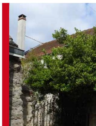
Mauvais exemple de cheminée en ciment positionnée en rive de toit et qui donc doit monter très haut pour pouvoir fonctionner
