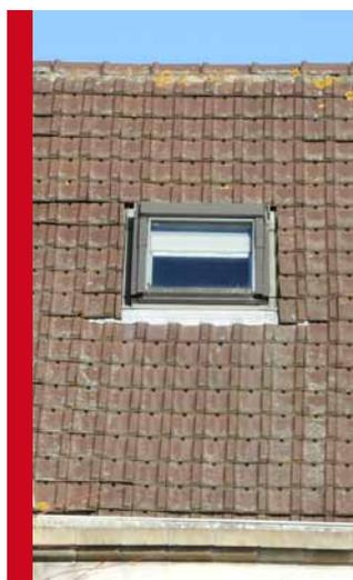
**Châssis de toit** très mal intégré à la couverture : surépaisseur, couleur, mise en œuvre...
