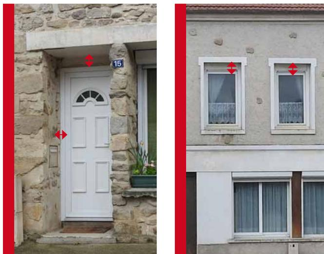
Les portes aussi doivent s'adapter à la baie ancienne. À gauche exemple de modèle préfabriqué «demi-lune» visible dans la France entière et sur tout type de bâti, à proscrire. À droite, ce sont les fenêtres qui sont trop petites en hauteur.
