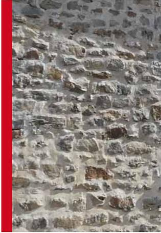
Dans le cas où les moellons restent apparents il ne faut en aucun cas que les joints soient en creux par rapport aux moellons, il doivent au minimum affleurer.
