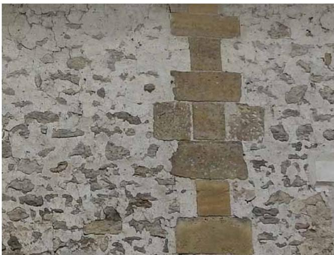
Exemple de harpage en pierre de taille permettant de rigidifier les maçonneries en moellons.
