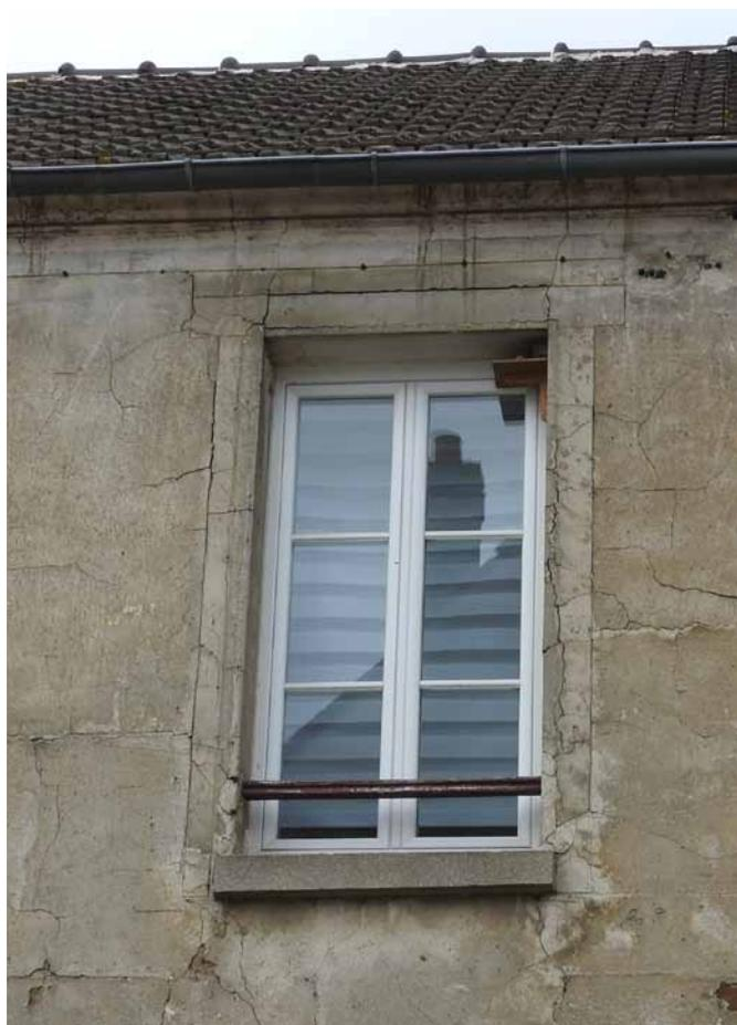
Exemple de fenêtre avec vantaux à 3 carreaux dont les profilés sont en adéquation avec le bâti. Exemple à suivre.
