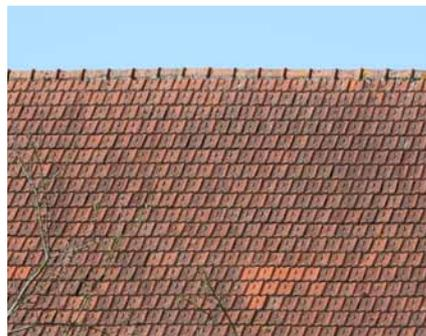
Tuiles mécaniques à emboîtement
