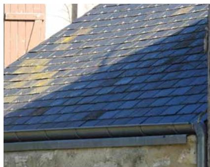
L'ardoise possède une bonne durabilité dans le temps, un poids réduit (qui permet des pentes plus fortes et de ce fait des formes de toits plus variées).
