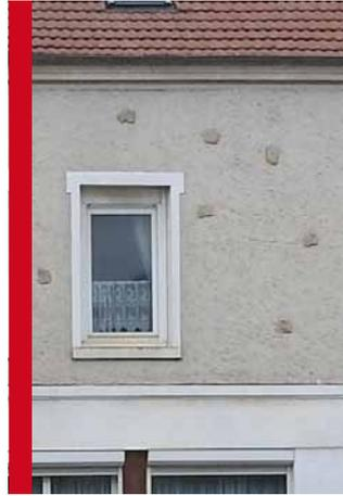
Pastiche d'enduit dit à «pierres vues» à éviter. Il est important de connaître les mises en œuvre traditionnelles pour éviter de les détourner dans le mauvais sens.
