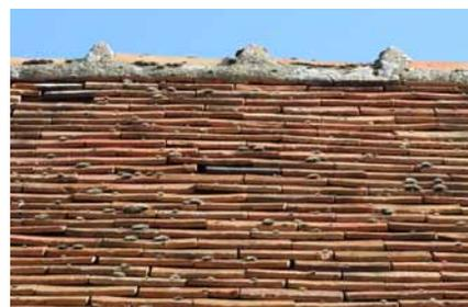
**La petite tuile plate** mesure approximativement 15 x 25 cm et pèse environ 1 kg. Elle est posée à joint croisé à raison de 65 à 80 unités au m<sup>2</sup>. Son accrochage sur les liteaux est assuré par des nez ou des talons moulés.
