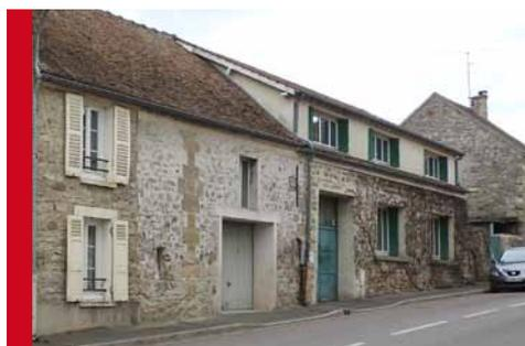
Type de surélévation en « lucarne rampante » sur l'ensemble de la maison. Cette typologie n'est pas adaptée, privilégier une surélévation complète avec une « extension par surélévation »
