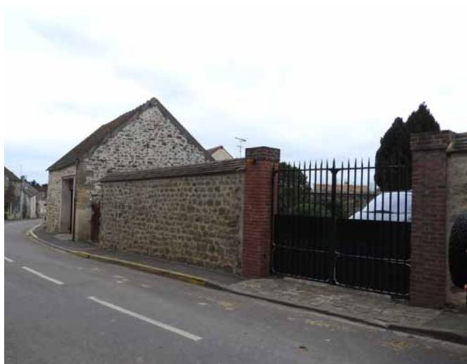
Exemple de piliers très simples en brique qui mettent en valeur l'entrée et le portail en fer forgé.
