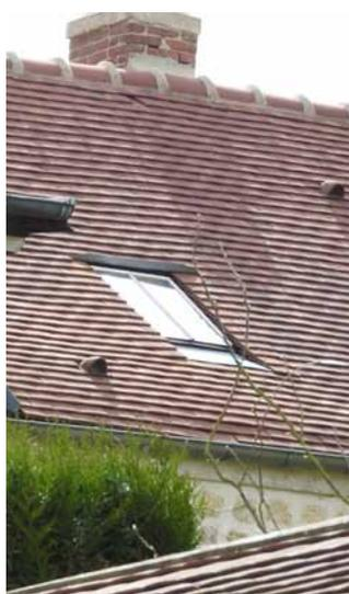
**Châssis de toit** mis en œuvre à fleur de la couverture. («Cast P.M.R.»)
