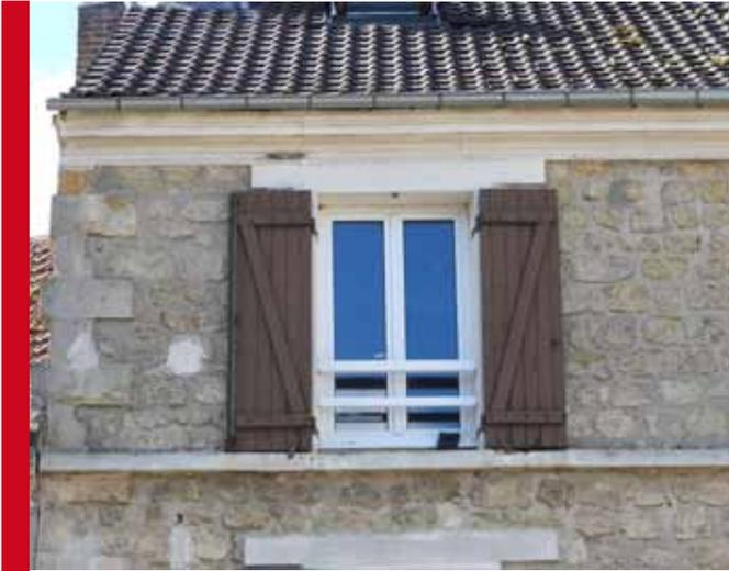
Sur cet exemple, les menuiseries et le garde-corps ont tout trois été remplacés par des éléments qui appauvrissent le bâti : larges montants de fenêtres en PVC, contrevents « en écharpe » et garde-corps en bois.
