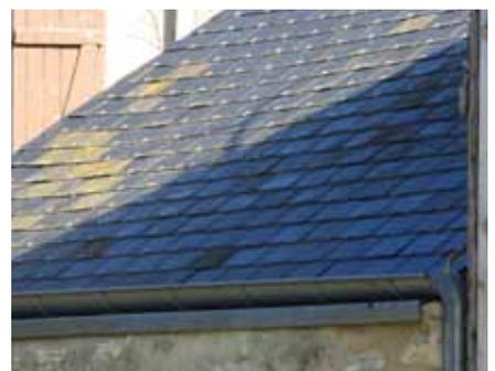
L'ardoise possède une bonne durabilité dans le temps, un poids réduit (qui permet des pentes plus fortes) et de ce fait des formes de toits plus variées).
