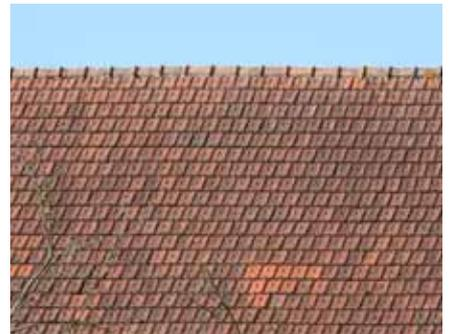
**Tuiles mécaniques à emboîtement**
