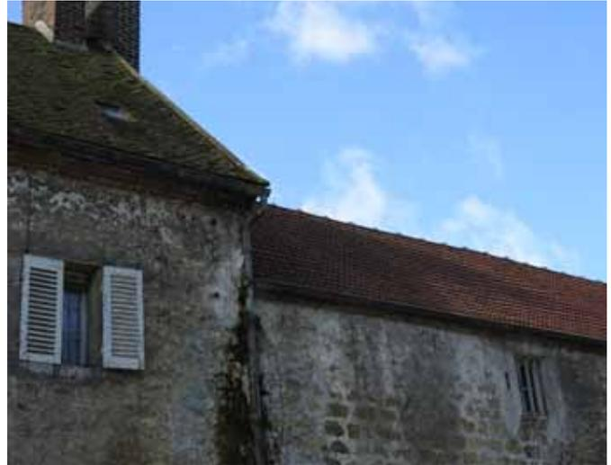
À droite les tuiles plates traditionnelles à gauche les tuiles mécaniques
