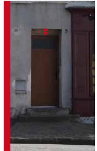
Les portes aussi doivent s'adapter à la baie ancienne. À gauche exemple de modèle préfabriqué «demi-lune» visible dans la France entière et sur tout type de bâti, à proscrire. À droite, la porte est trop petite en hauteur mais le modèle peut être adapté s'il est peint.
