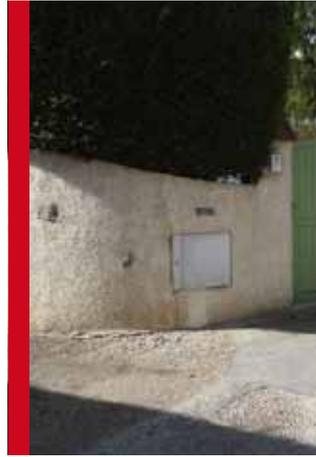
Pastiche d'enduit dit à «pierres vues» à éviter. Il est important de connaître les mises en œuvre traditionnelles pour éviter de les détourner.
