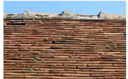
**La petite tuile plate** mesure approximativement 15 x 25 cm et pèse environ 1 kg. Elle est posée à joint croisé à raison de 65 à 80 unités au m<sup>2</sup>. Son accrochage sur les liteaux est assuré par des nez ou des talons moulés.
