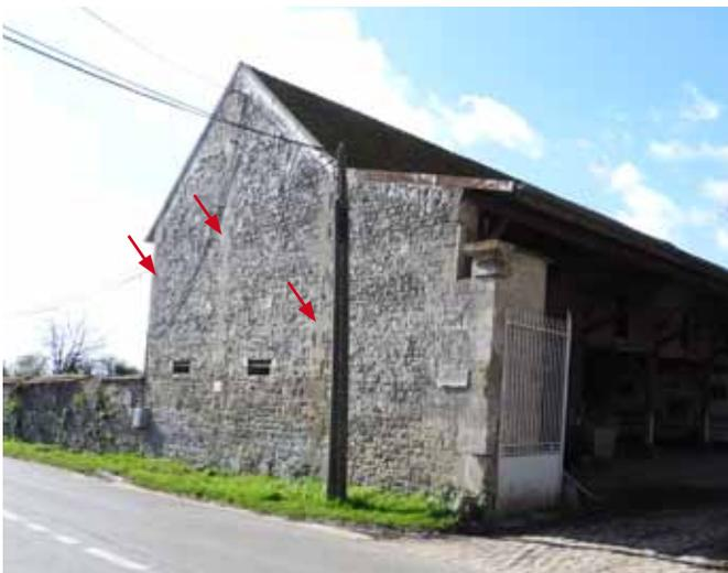
Exemple de harpage en pierre de taille intermédiaires permettant de rigidifier les maçonneries en moellons.
