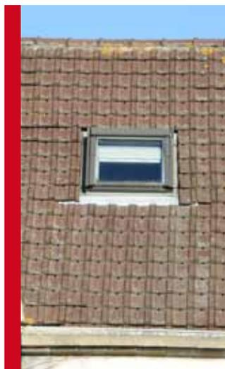
**Châssis de toit** très mal intégrée à la couverture : surépaisseur, mise en œuvre...
