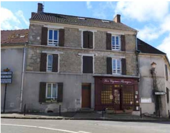
VARIANTE 1 - Les diverses transformations opérées sur cette façade ne contribuent pas à sa mise en valeur : menuiseries des fenêtres et des volets non adaptées, garde-corps en bois, ciment sur le RdC et absence d'enduit aux étages.
