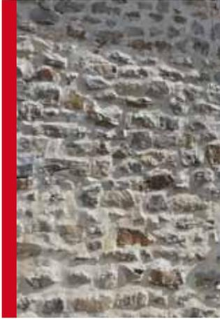
Dans le cas où les moellons restent apparents il ne faut en aucun cas que les joints soient en creux par rapport aux moellons, ils doivent au minimum affleurer.
